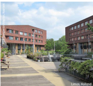
Parkeringskonstruktion under byrum Limos, Holland
