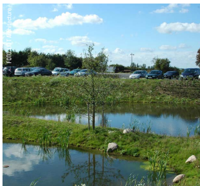
Parkering med integreret regnvandshåndtering
