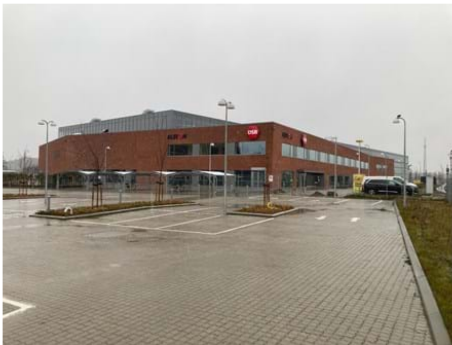
Referencefoto – eksempel på facadeskiltning (DSB).
